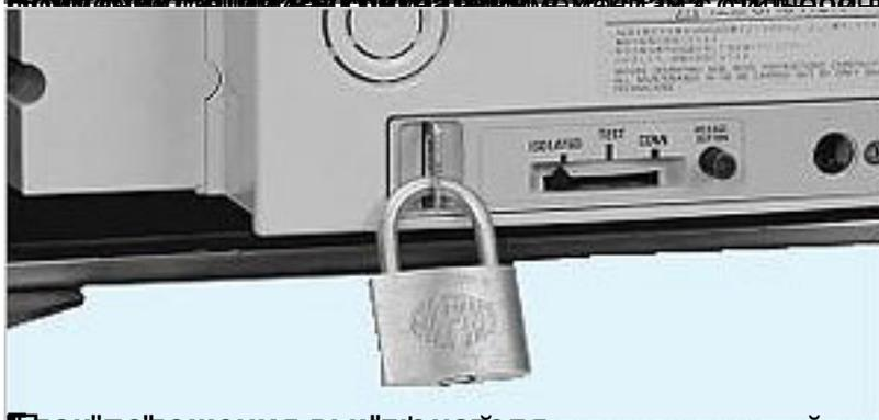
Блокировка осуществляется при помощи замка на панели управления "Блокировка",
